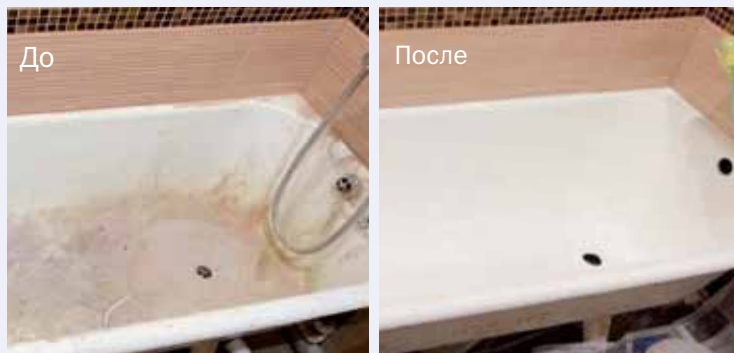
▲ Результат до и после применения жидкого акрила
